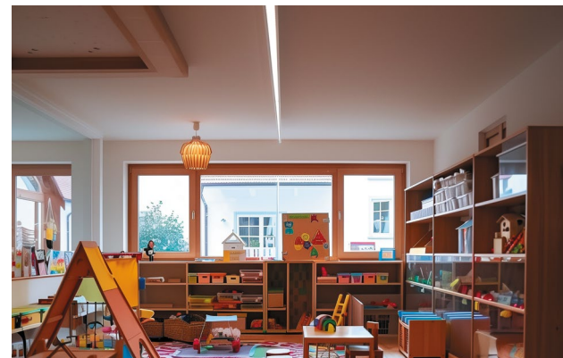
TRIAC dimmbare Deckenaufbauleuchte im Kindergarten 200110
