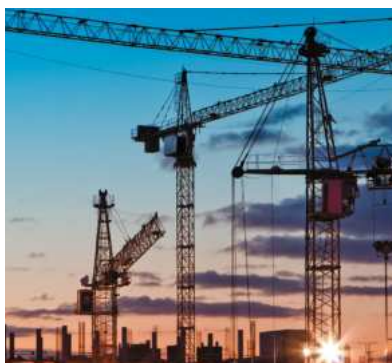
Gru per edifici
